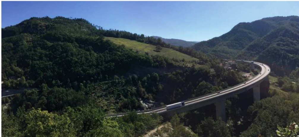
Vista del versante monitorato dal teodolite
